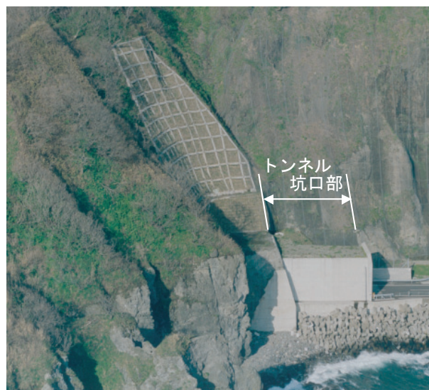
写真-1 トンネル坑口部の例
