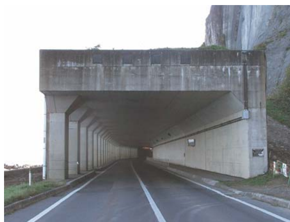
写真-1 RC 製落石防護覆道の一例
