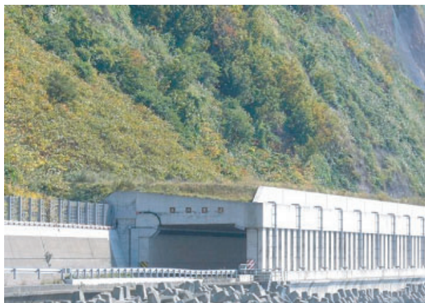
写真-1 落石防護覆道の一例
