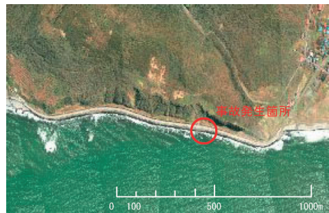
写真-1 事故が発生した海岸道路
