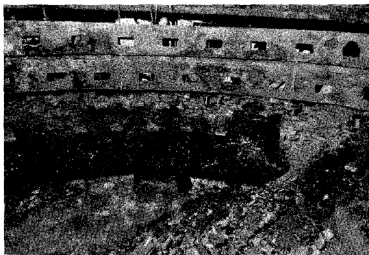
図-3 炉腹部下端の溶食
