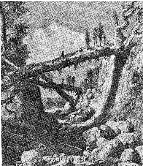
図-7 谷間に自然に架けられた木の幹の橋
