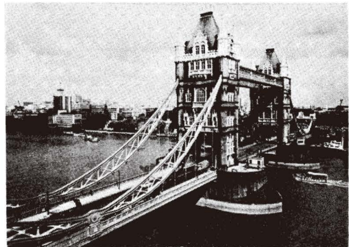
イギリス、コンドンのタワア・ブリッジ(跳開橋, 1,894)
