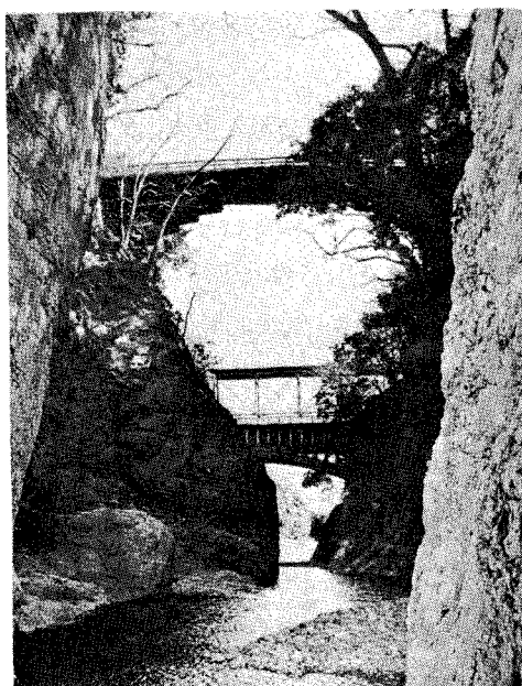
図一16 山梨県甲斐の猿橋（木造突桁）
