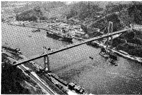
図一29 広島県の尾道大橋（1968，斜張橋）
