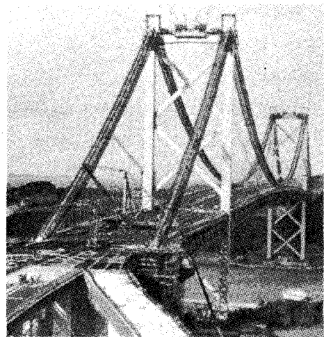
図一34 福岡県の関門橋工事中の図 (1973 完成, 3 径間補剛構吊橋)
