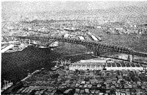
図一33 大阪南港の港大橋 (1973, ゲルバートラス)
