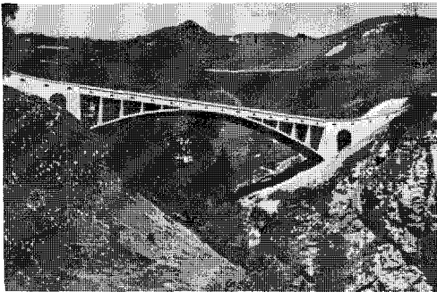
写真一9 パル・チール橋の立体的安定美 (スイス, 逆ランガー桁, 1925)
