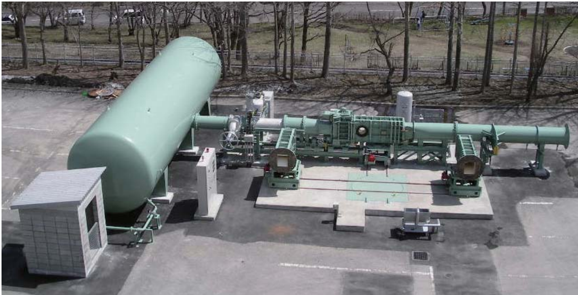
風洞試験設備の全景(上屋を設置する前の様子)
