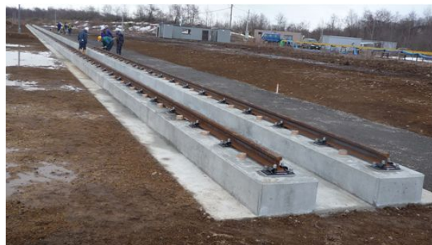
平成21年3月工事の完成検査
