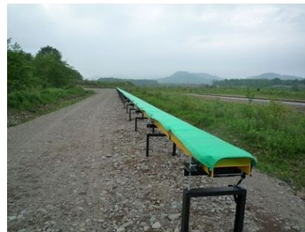
軌道に施した防護カバー
