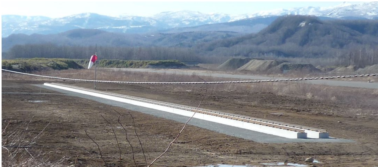
図 14：平成20年度に建設したフルサイズ高速走行軌道(全長150 m)の全景 (右側奥に滑走路が見える)
