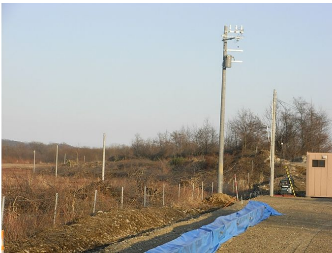
北海道電力の給電線設置
