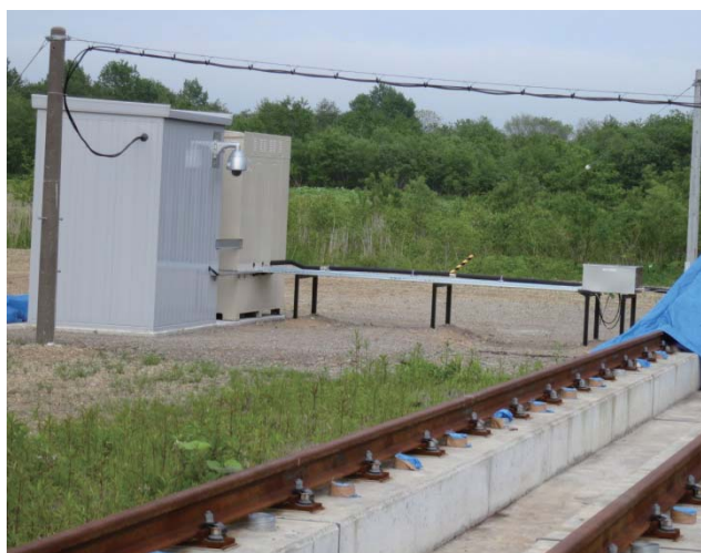
図3 計測器・ポンベ保管庫
