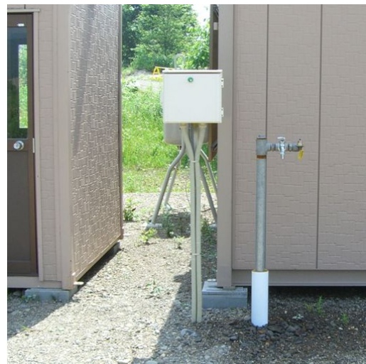
実験室・計測室付近に新設した給水蛇口
