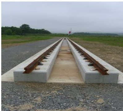
平成20年度に設置した150mの軌道
