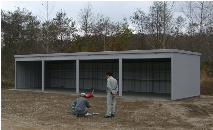
図5: 実験準備・機材保管の建屋
