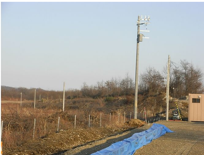
北海道電力の給電線設置
