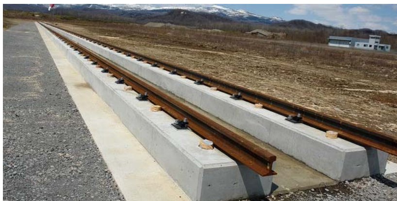
図 1 : フルサイズ軌道装置の概観 (白老実験場)
