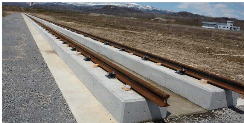
図1:300m 級フルサイズ軌道装置の概観(白老実験場)
