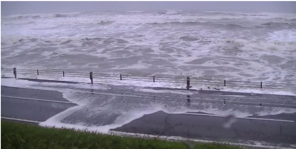
写真-3.2.1.2 高波浪時の緩傾斜護岸背後道路への越波状況
