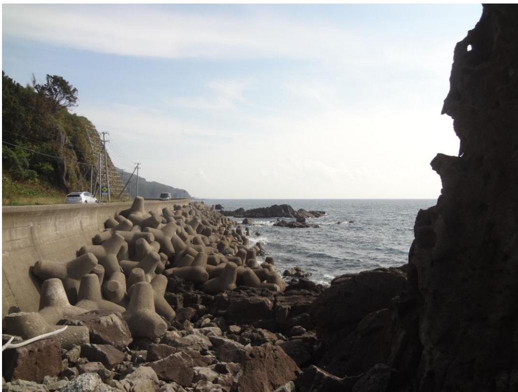
写真-3.1.2.3 事故後に消波改良された護岸前面の全景
