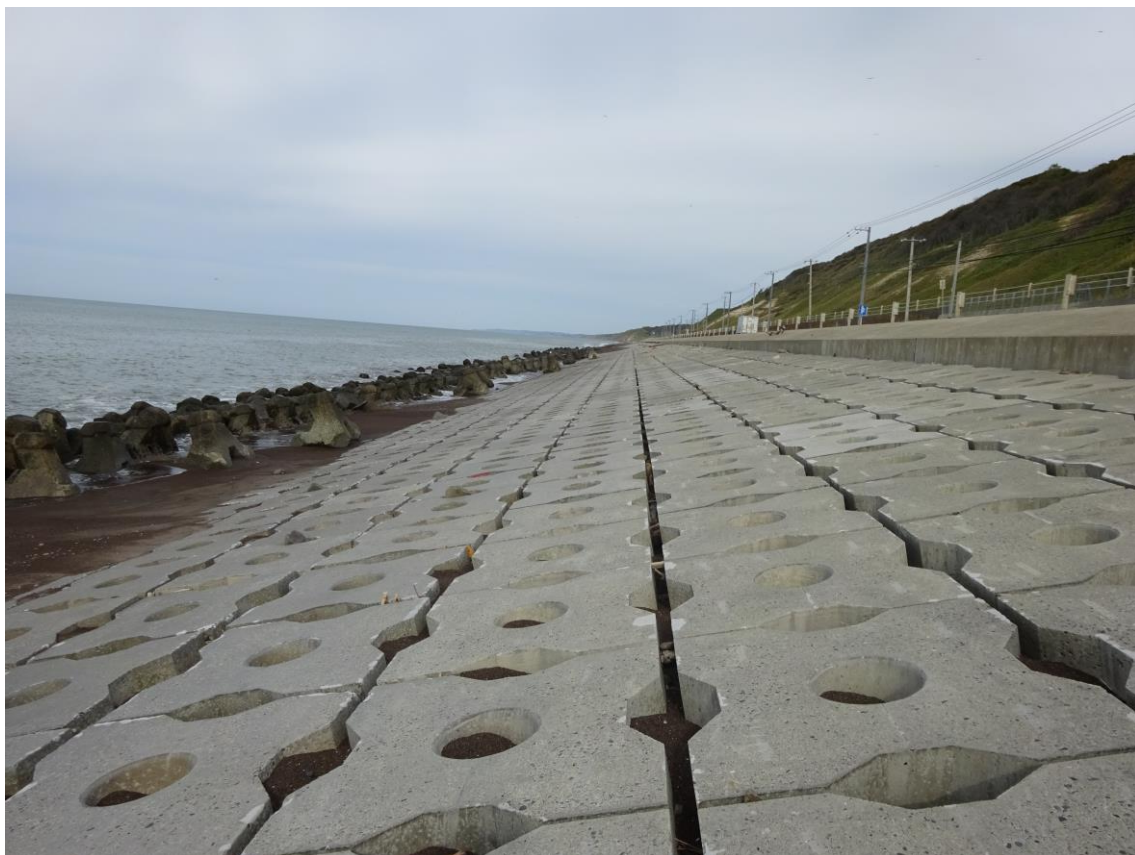
写真-3.2.1.1 現地緩傾斜護岸
