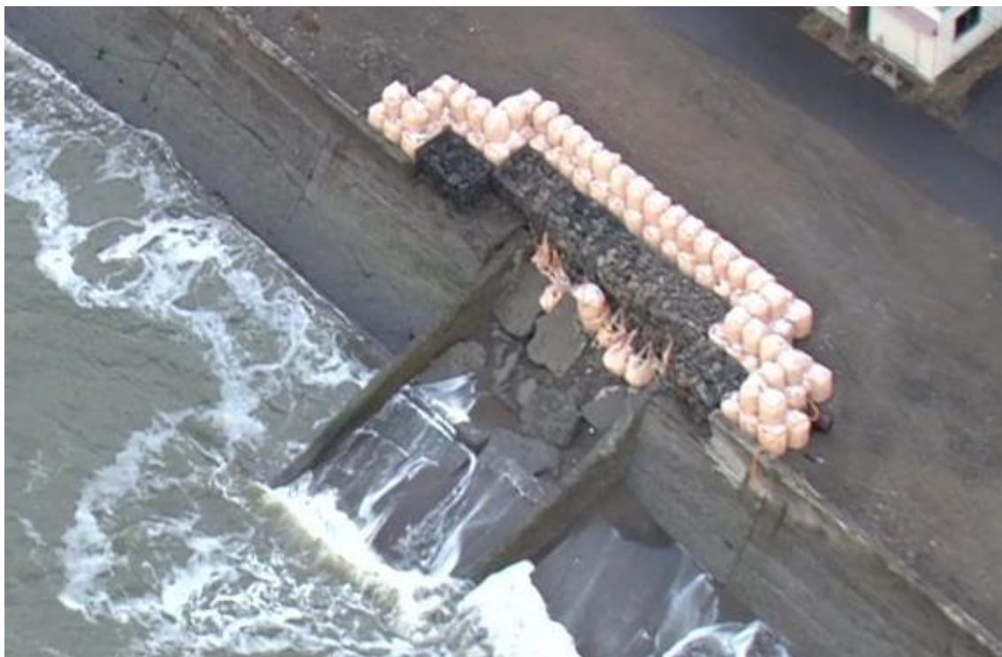
写真-6.5.2.1 大型土のうにより応急対策が講じられた船揚場斜路
