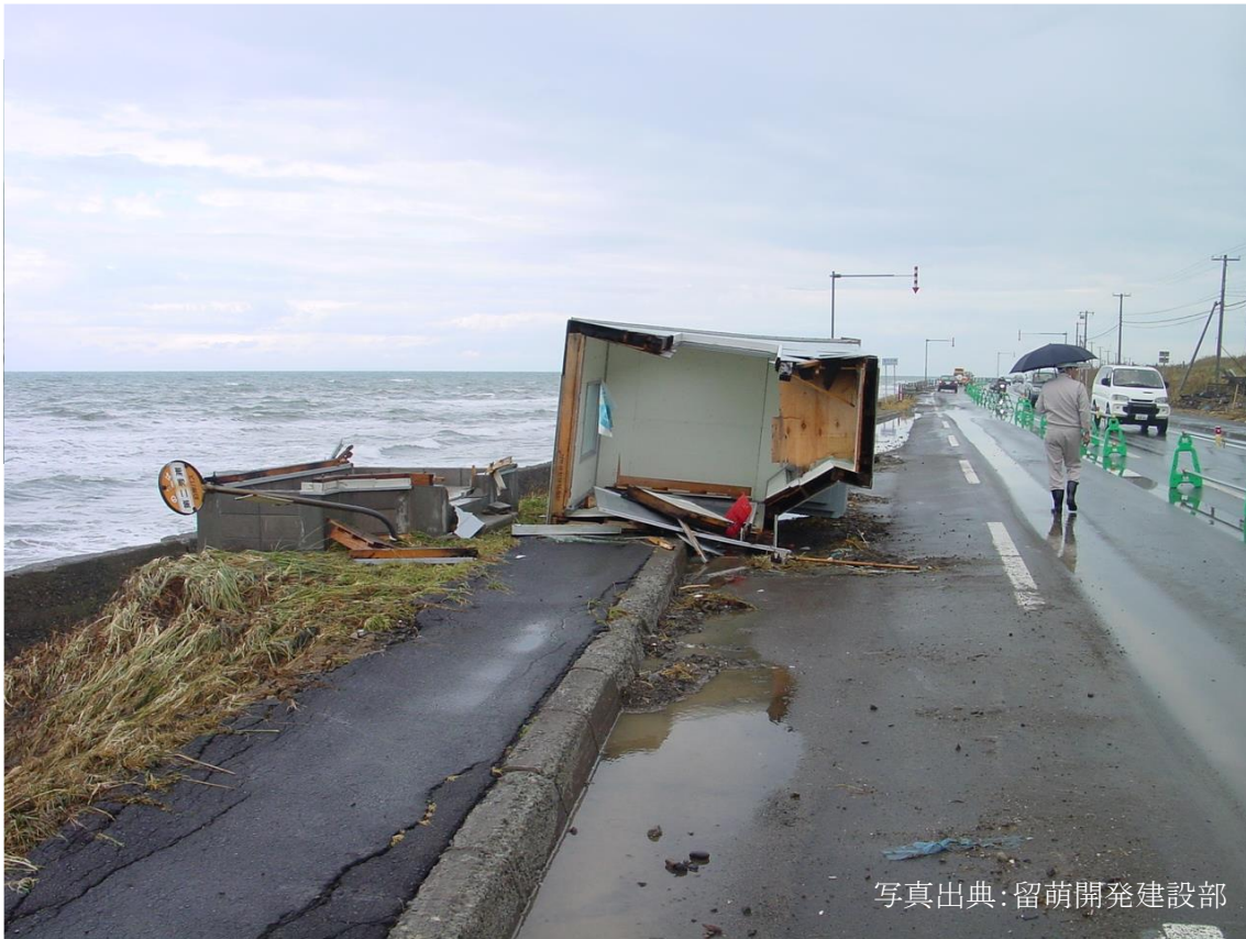
写真-2.1.3.1 打上げ型越波による護岸背後地における家屋の倒壊
