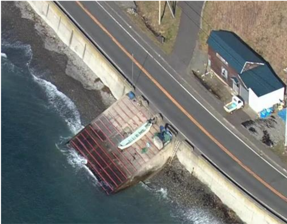
写真-6.5.1.1 護岸直角形式の張り出し式斜路
