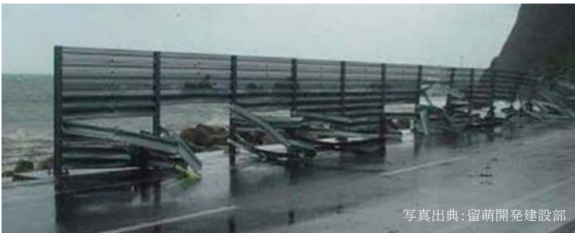
写真-2.1.3.2 打上げ型越波による防波フェンスの被災
