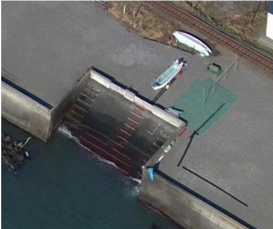
写真-6.5.1.3 開閉式ゲートが設置された船揚場斜路
