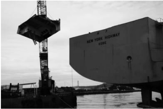
(a) クレーンによる甲板の運搬
