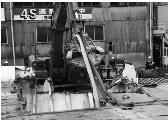
(a) 甲板解体試験
