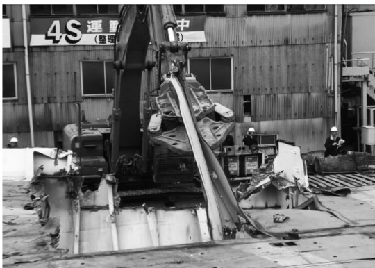
(a) 甲板解体試験
