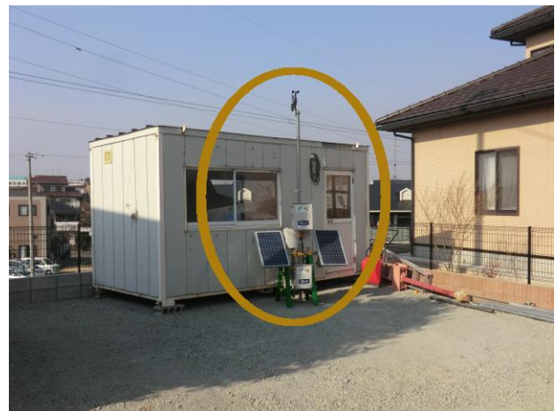
図2 実証実験システム設置の全景
