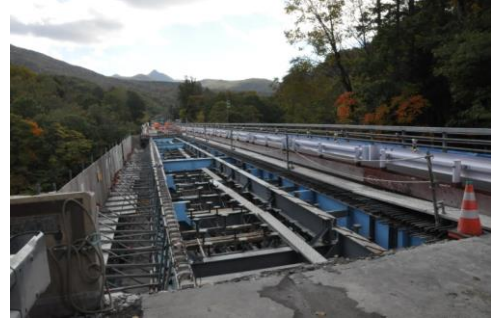
写真6 片側床版の完全撤去状況
