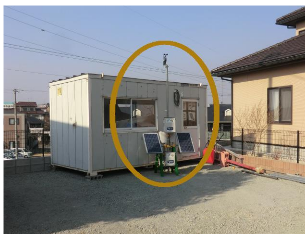
図2 実証実験システム設置の全景
