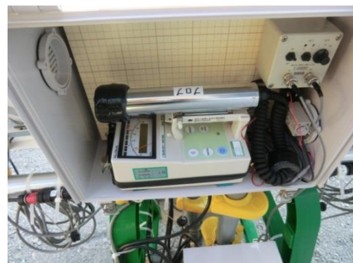
図5 設置したシステム機器(B)
