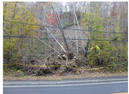
図7 地点3の崩壊箇所全景
