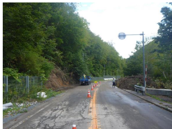
図 4 地点 1 の斜面崩壊時の状況
