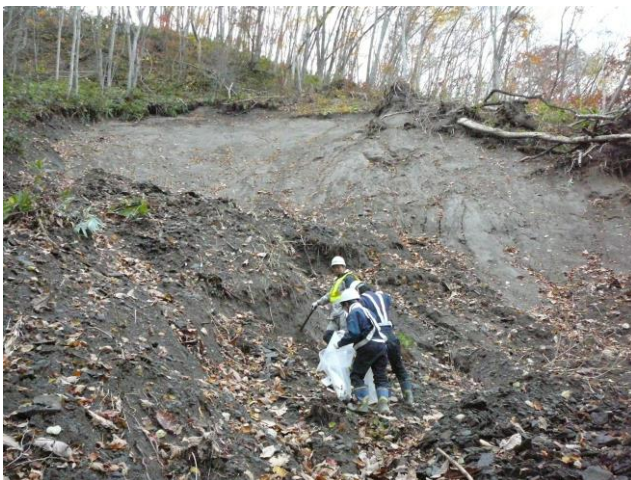
図 12 地点 3 崩壊箇所の正面全景
