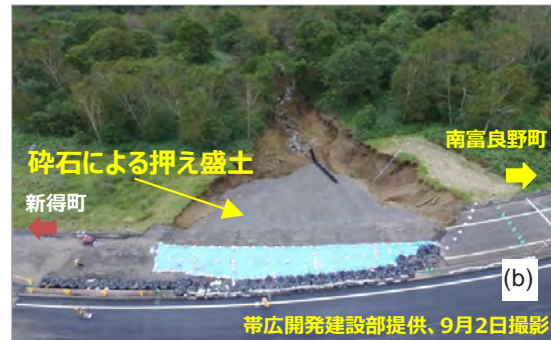
図 14 盛土崩壊状況： (a)山側から俯瞰 (b)応急復旧状況
