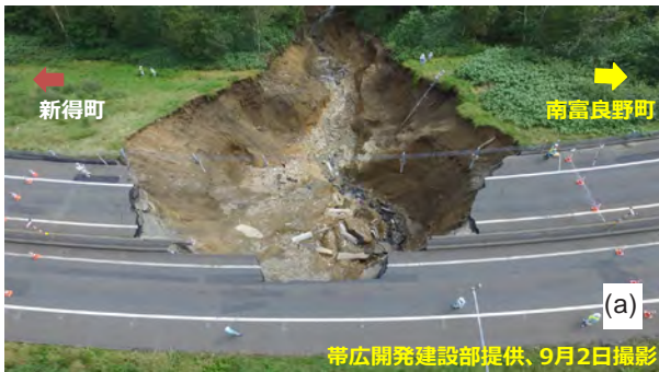
図 14 盛土崩壊状況： (a)山側から俯瞰 (b)応急復旧状況
