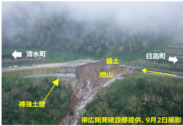
道路損壊 (L=100m)
