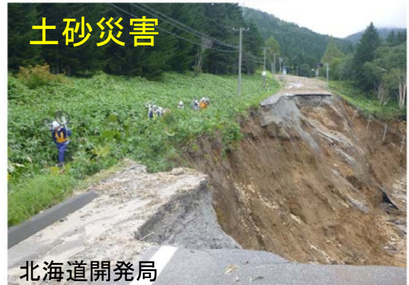
⑦国道274号 日高町 道路調査の状況 (H28.9.4)
