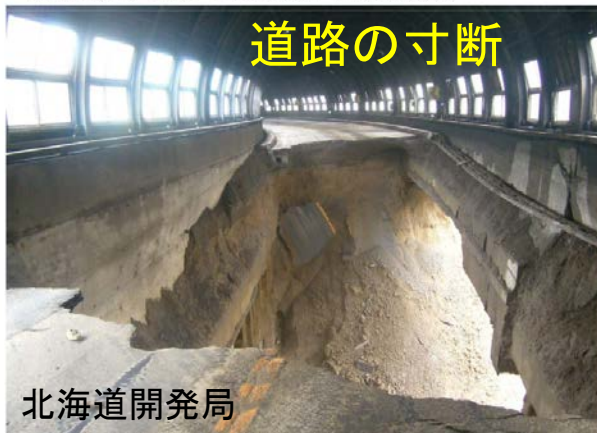
④国道274号 日高町 三国の沢覆道 (H28.9.3の状況)
