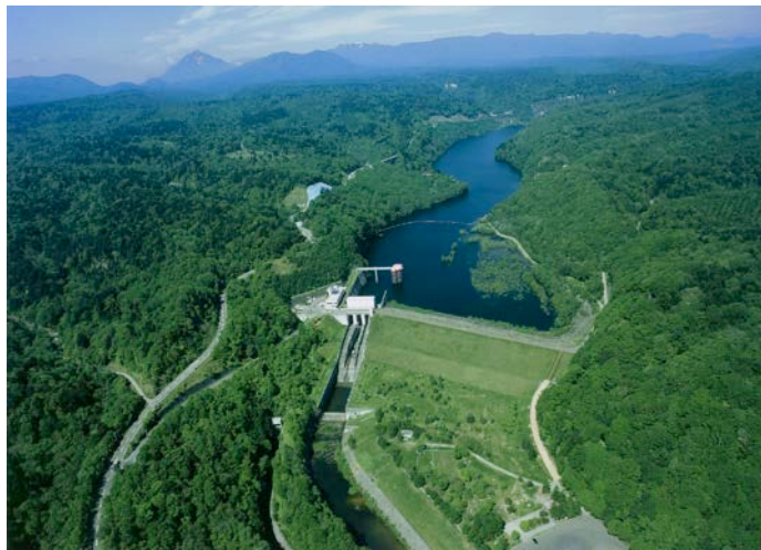
図 5.7 漁川ダム（国土交通省札幌開発建設部ホームページ 6) ）
