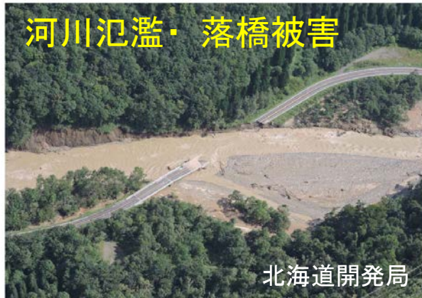
国道274号 日高町 岩瀬橋 (H28.9.1の状況)
