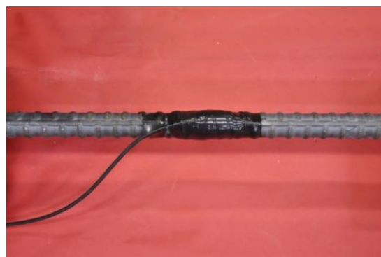
写真-4.28 防水加工の完了状況
