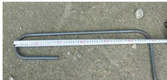
写真-4.6 鉄筋の加工寸法検収確認
