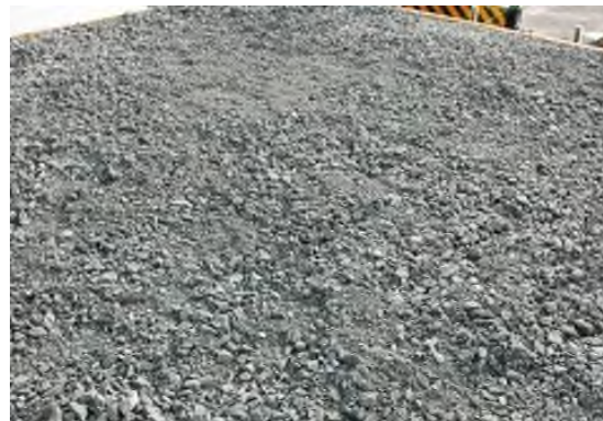
写真-4.31 頂版上の碎石緩衝材
