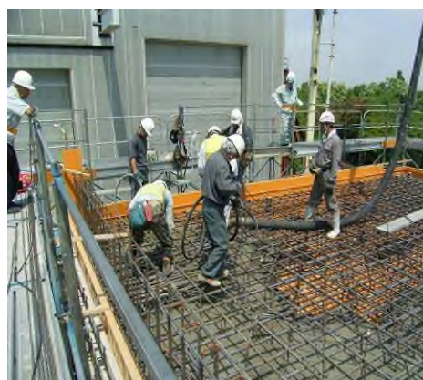
写真-4.15 頂版のCo打設状況
