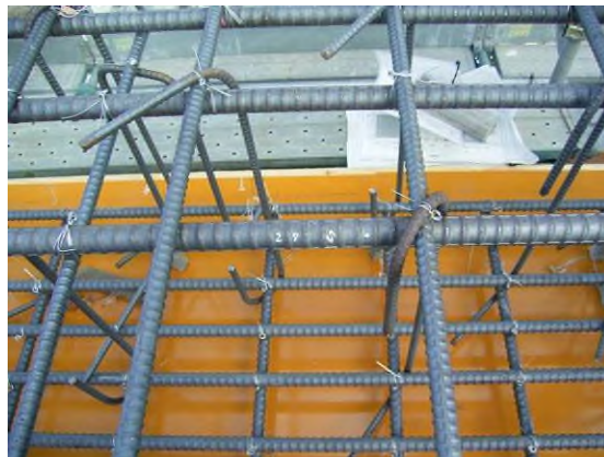
写真-4.13 頂版上面の軸方向鉄筋 D29
