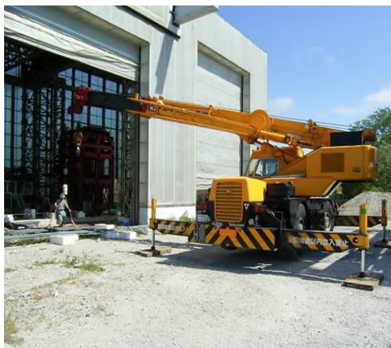
写真-4.7 ひずみゲージを設置した鉄筋の搬出状況
