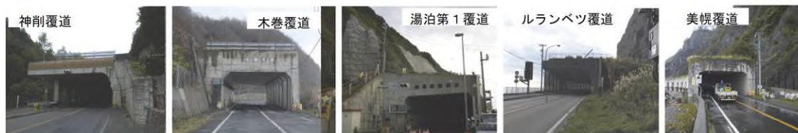
写真-3.1 各ロックシェッドの全景
