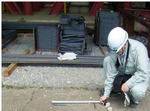
写真-4.5 鉄筋の材料検収
