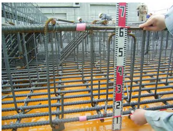
写真-4.14 頂版の鉄筋検査状況
