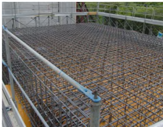
写真-4.12 頂版の配筋状況
