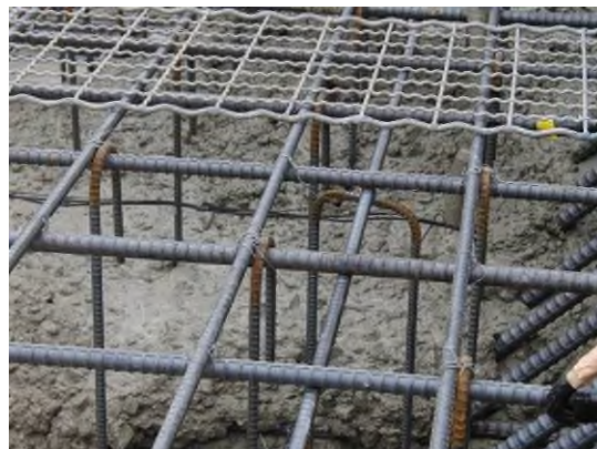
写真-4.9 底版コンクリートの打設状況
