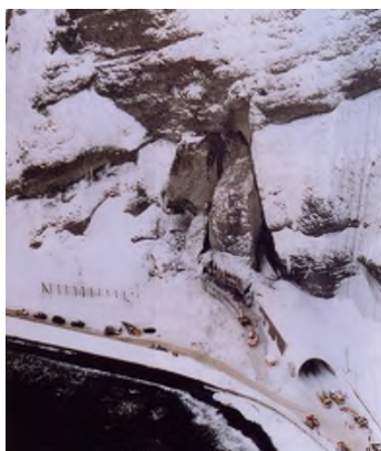
写真-1.2 北海道古平町一般国道229号豊浜トンネル岩盤崩落事故（1996年2月）
