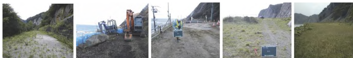
写真-3.2 各ロックシェッドの緩衝材の全景
