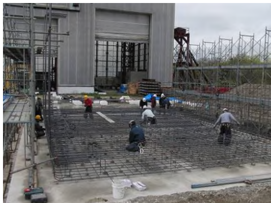
写真-4.8 底版の鉄筋組立状況
