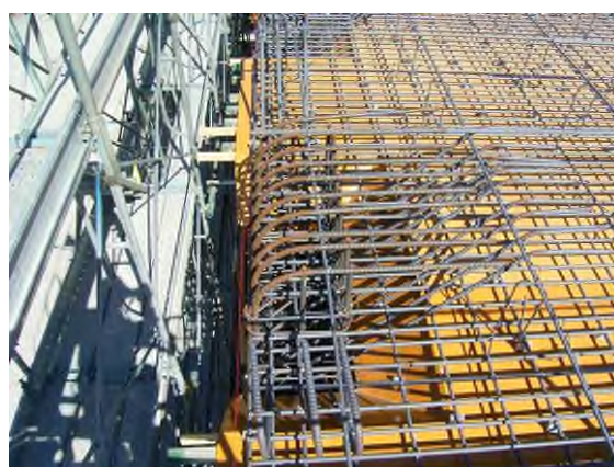
写真-4.11 柱上面の配筋状況
