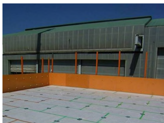
写真-4.17 TLASの2層目のEPS設置状況
