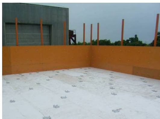
写真-4.16 TLASの1層目のEPS設置状況
