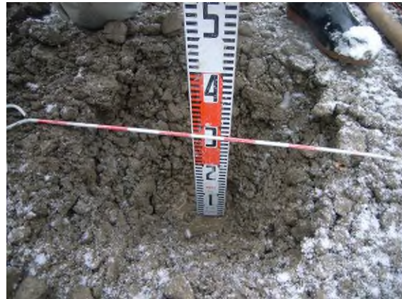
写真-4.4 剛基礎下面の基礎状況
