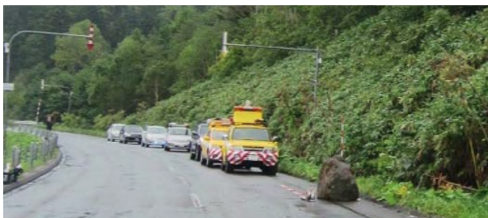
写真-2.2 北海道上川町一般国道 273 号落石事故（2014 年 9 月 7 日（日）） （落石 1m×1.2m 程度, 車両 1 台の物損のみ） （国土交通省北海道開発局旭川開発建設部 HP 137 ）より）
