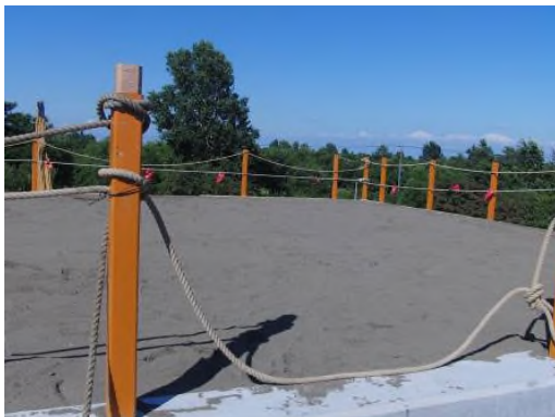
写真-4.30 頂版上の敷砂緩衝材
