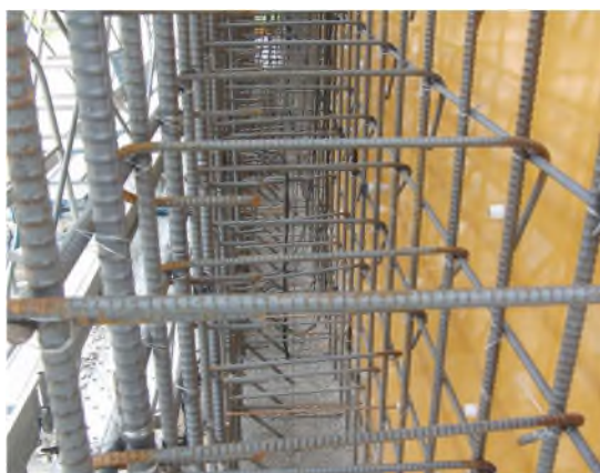
写真-4.10 側壁の配筋状況
