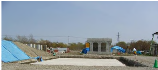
写真-4.3 試験体下面の剛基礎状況
