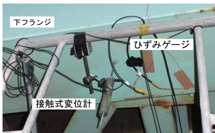
写真 3 ひずみおよびたわみ計測状況
