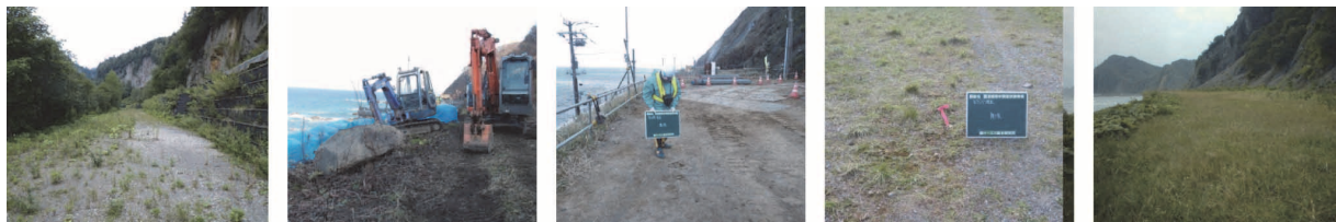
(a) 神削覆道 (b) 木巻覆道 (c) 湯泊第1覆道 (d) ルランベツ覆道 (e) 美幌覆道
