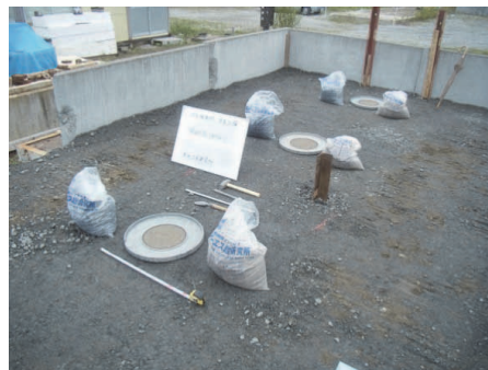
写真－15 碎石緩衝材の締固め密度の計測状況
