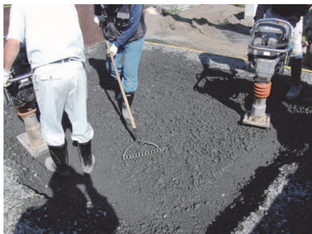
写真－13 碎石緩衝材の転圧状況 (G70-2 層目)
