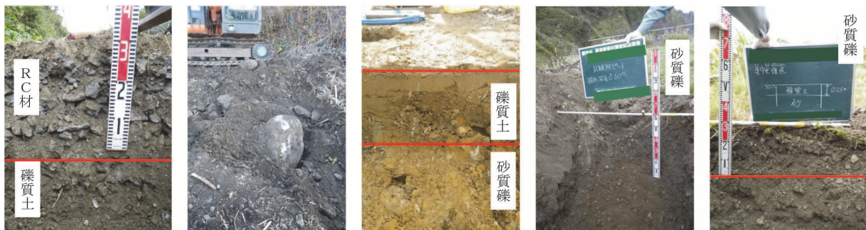
(a) 神削覆道 (b) 木巻覆道 (c) 湯泊第1覆道 (d) ルランベツ覆道 (e) 美幌覆道
