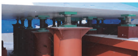
写真－14 衝撃荷重用ロードセルの配置状況
