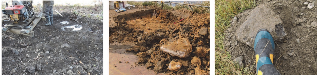
(b) 木巻覆道 (c) 湯泊第1覆道 (e) 美幌覆道
