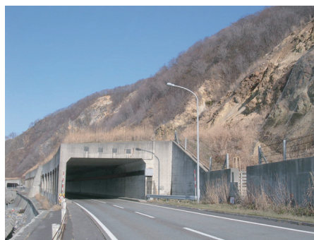
写真-1 RC製ロックシェッドの一例
