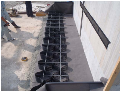
(1) ジオセルの設置 (最下段)
