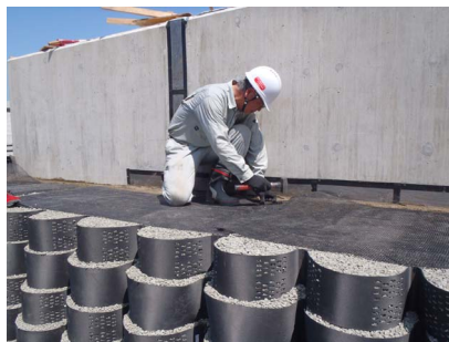
(5) ジオネットの敷設
