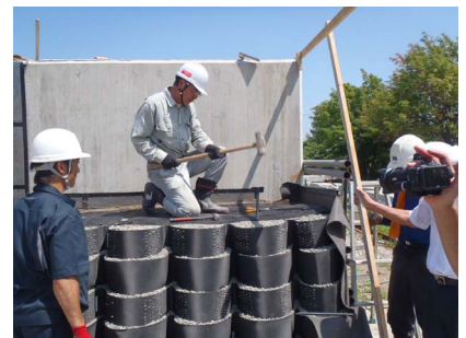
(6) 鉄筋アンカーの打設
