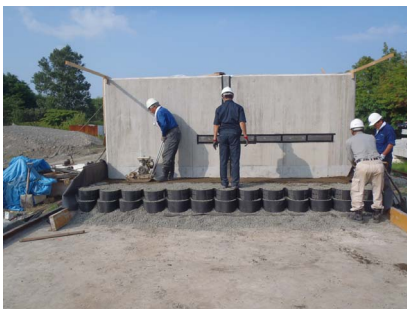
(4) 中詰材投入・転圧 (2 段目)
