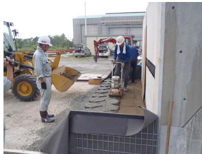
(2) 中詰材投入・転圧 (最下段)
