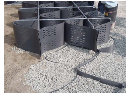
(3) ジオセルの設置 (2 段目)
