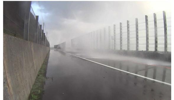
写真-4 防波フェンスに衝突後の越波状況
