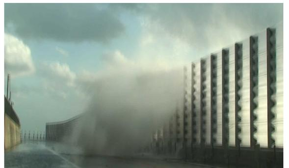
写真-5 防波フェンスを越えた水塊の打ち込み状況
