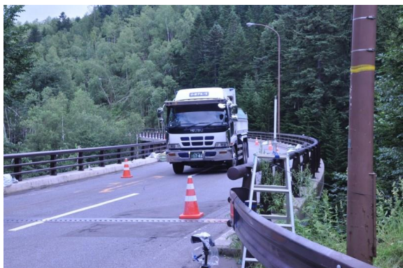
写真 1 大型車両による実験状況
