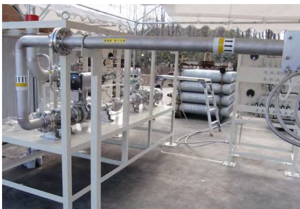
図1 GG-ATR エンジン冷走試験設備
