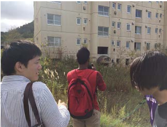
図9 洞爺被災地区の見学(集合住宅)
