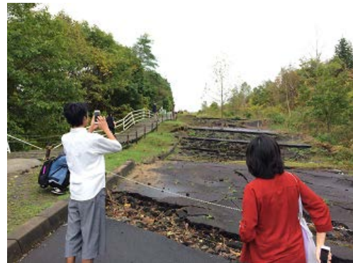
図8 洞爺被災地区の見学(国道)
